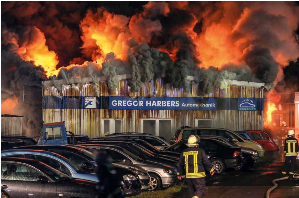
Großbrand in einer Autowerkstatt in Eckelshausen.
